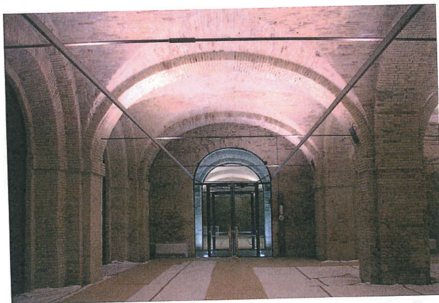
8 A servizio delle sale espositive sono previsti impianti di climatizzazione a fan coil suddivisi per circuiti destinati per ogni tipo di attività.
