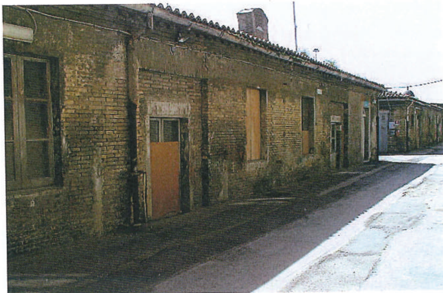
5 Corpo servizi tecnici prima del restauro.
