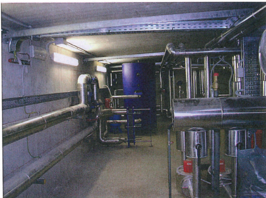
4 Sottocentrale termofrigorifera.
