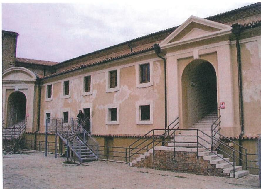
2 Cortile interno prima del restauro.
