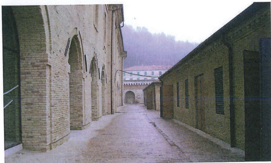
6 Corpo servizi tecnici dopo il restauro.
