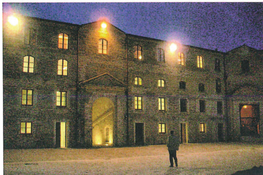
3 Facciata interna restaurata.
